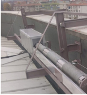
Çatıda 3 kol, motor ve tambura düzgünce sarılı halatlar.
