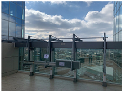
Parapetsiz balkondaki motor ve tamburun montaj şekli
